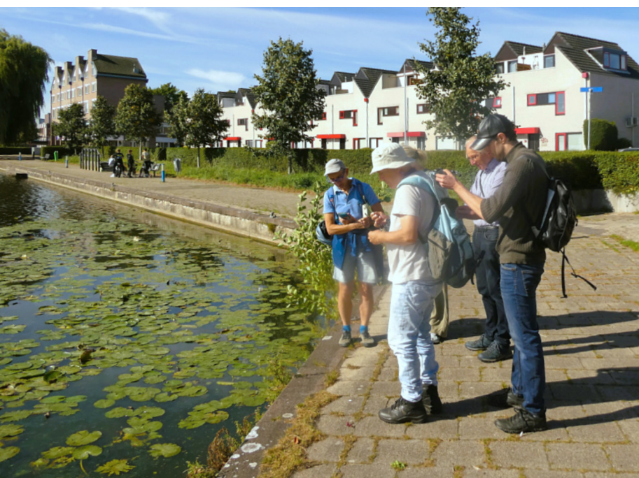
Groep 2 inspecteert de kademuurtjes. Foto: Fred Reeder
